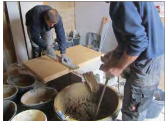
Innendämmung aus Holzweichfaserplatten ohne synthetische Stützfasern, Putz aus Lehm
